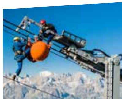
Travaux de maintenance sur le téléphérique du Mont-Gelé: les marquages pour la sécurité aérienne doivent être déplacés chaque année.
