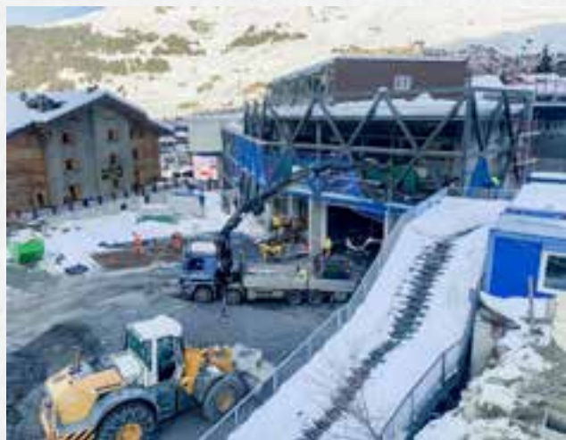
État du chantier le 15 décembre 2021, une semaine avant l'ouverture. «La gare ne ressemblait à rien, c'était le stress total.»
