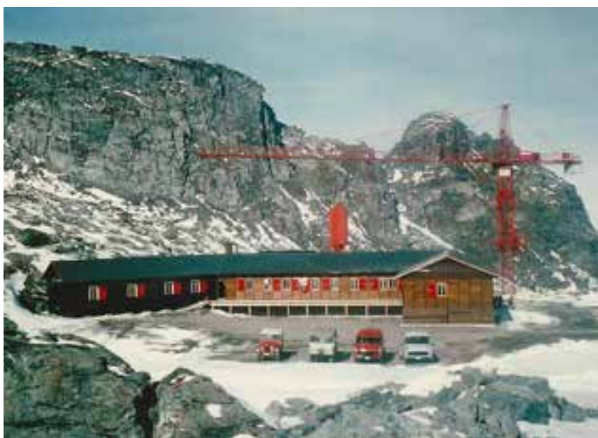
Pour loger et nourrir les ouvriers, un grand bâtiment est construit au col des Gentianes en 1978.
