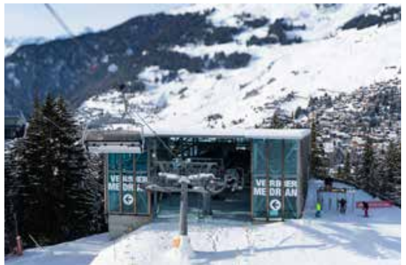
La gare de départ du télésiège débrayable Le Mayentzet, réalisée par le bureau FIMA Architecture en 2012.
