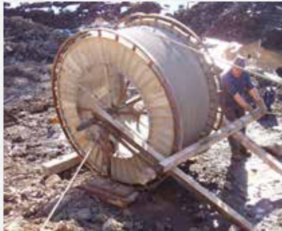
Pierre-Denis Perraudin freine le déroulement du câble.
